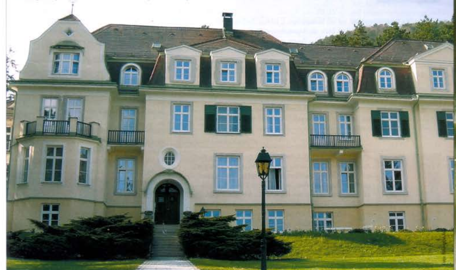
Ehemaliges Lungenanatorium: Einsatz von selbstreinigendem Fensterglas.
